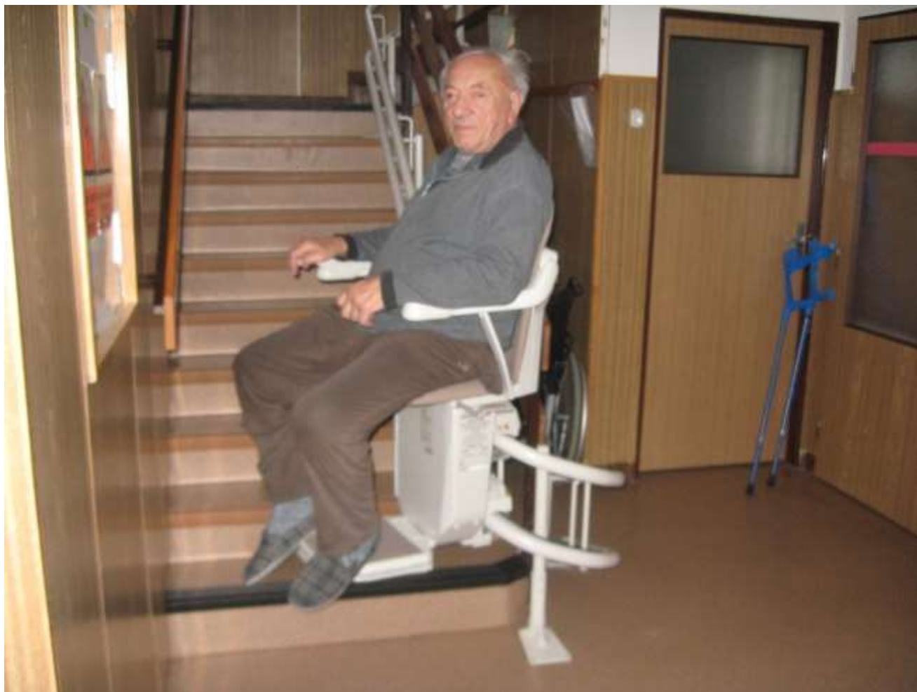
Schodišťová sedačka v budově „B“
