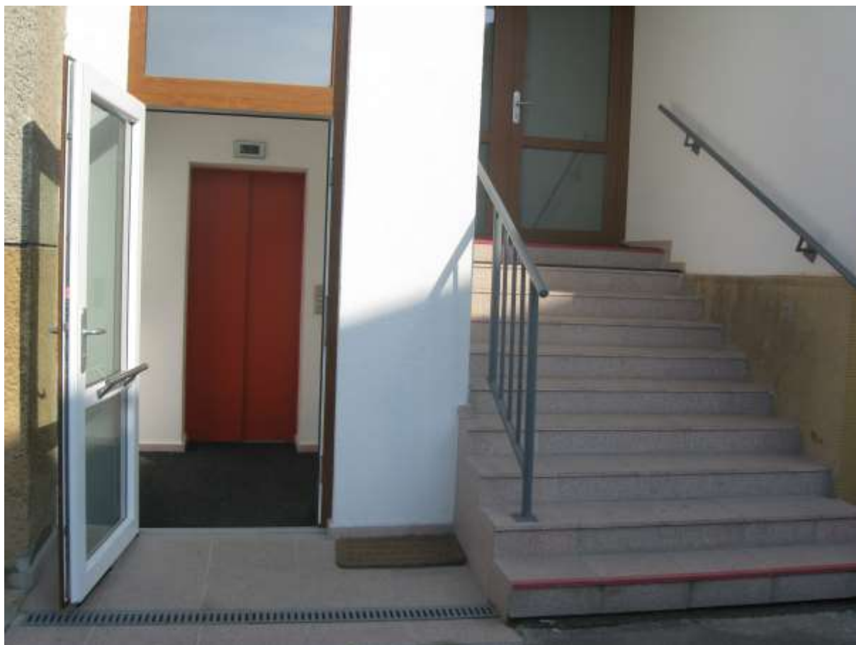
Výtah v hlavní budově
